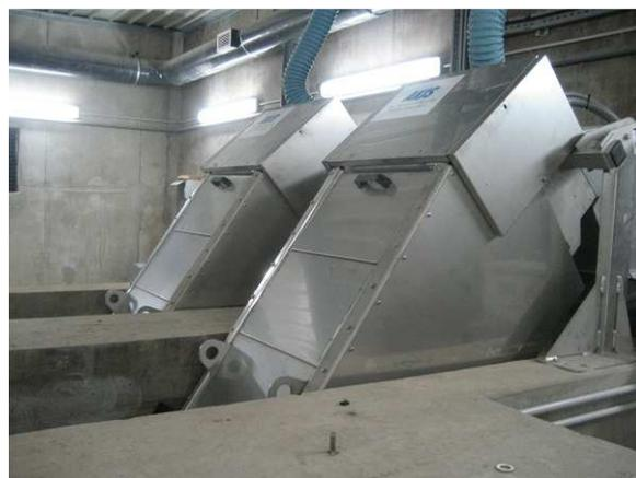
Les pieds de support adaptés permettent de faire pivoter la machine vers une position horizontale pour simplifier l'accès et la maintenance. La première marche d'escalier à basse friction en bas de la machine est conçue pour maintenir un constant écartement entre les lames et permet d'augmenter la protection contre le sable.
