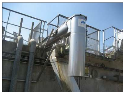
Compacteur à vis avec trappe de contre pression
